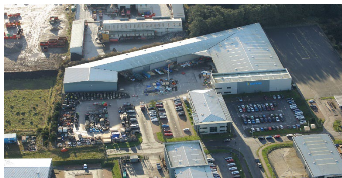
Immeuble Hydrasun, à Aberdeen
